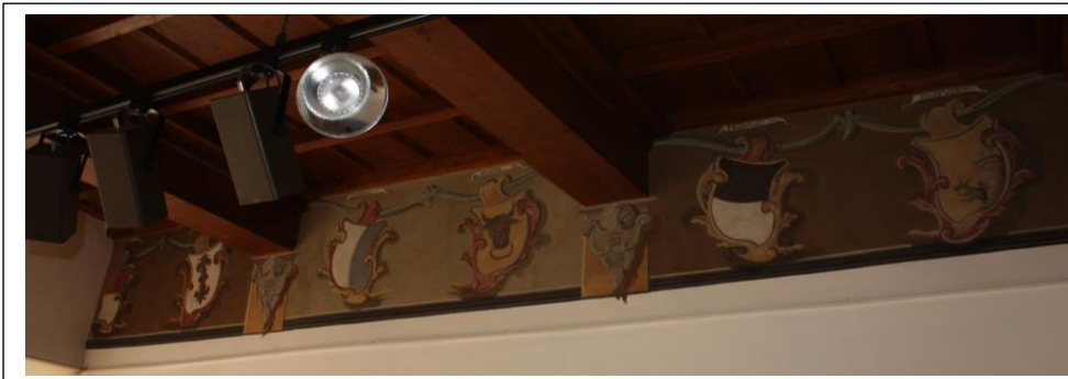
Sala della Giustizia, fregio perimetrale della parete meridionale.
